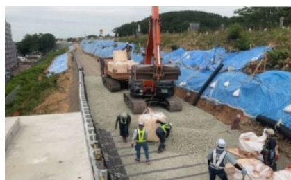
（施工中の様子）
