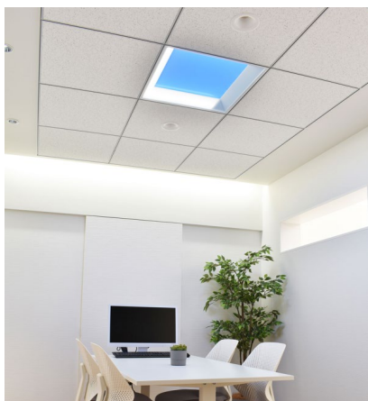
(LEDの設置事例)
