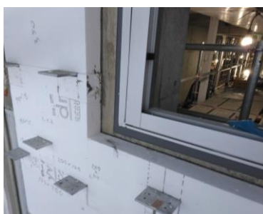
(製品取付工事中)
