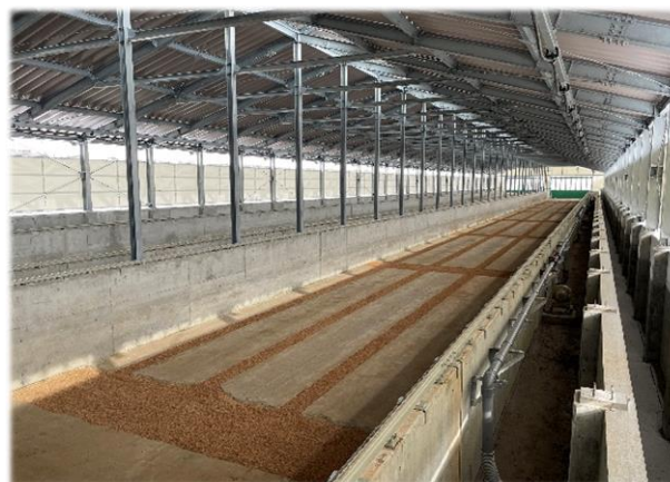
(発酵槽床面エアレーション配管)
